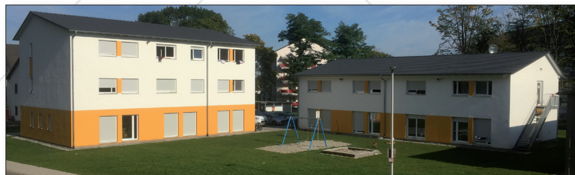
2016 wurde die neue Gemeinschaftsunterkunft am Waldweg 12 fertiggestellt.
