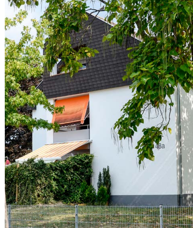
Effiziente Heizungsanlage und neue Optik: das modernisierte Mehrfamilienhaus in der Butschbacher Straße 48 a
