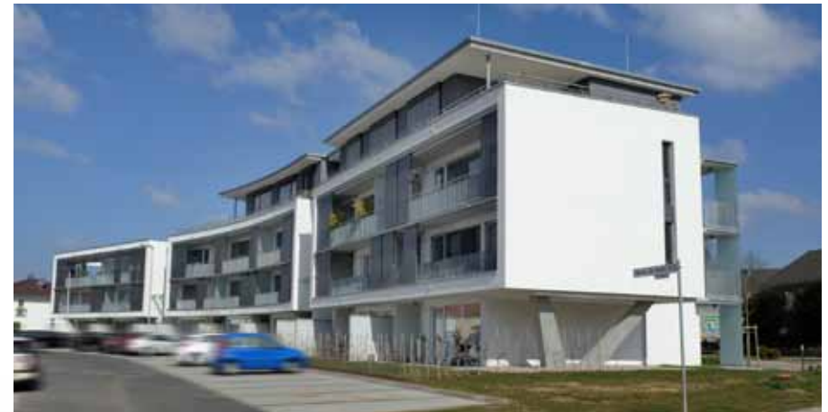
Fertigstellung des modernen Mehrfamilienwohnhauses an der Charles-de-Gaulle-Straße 2, 4, 6
