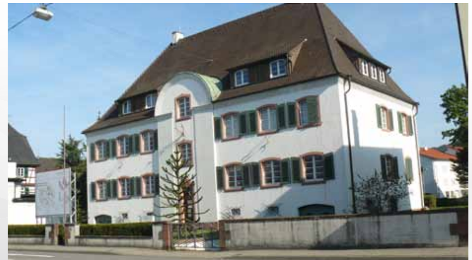
2015 hat die Städt. Baugesellschaft das Wohn- und Geschäftshaus an der Hauptstraße 23 a erworben und nutzt einen Teil der Räumlichkeiten als Geschäftsstelle.
